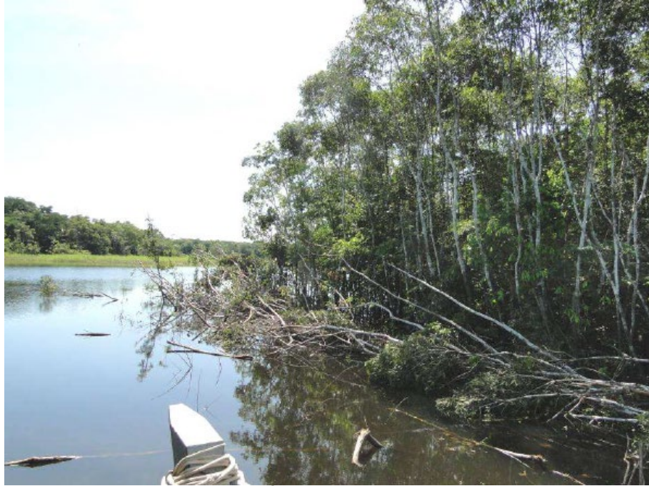
Figura 2.15: Árvores derrubadas em APP
